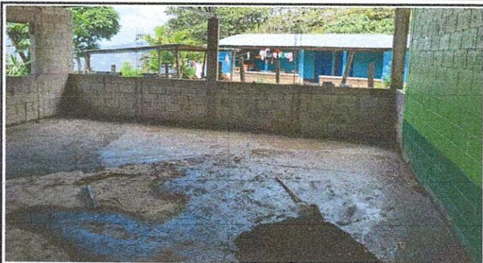
Foto 1: Mejoramiento de levantado de muros y estructura de columnas
