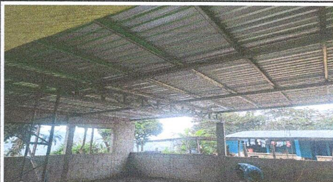
Foto 2: Mejoramiento de estructura y cubierta de lámina
